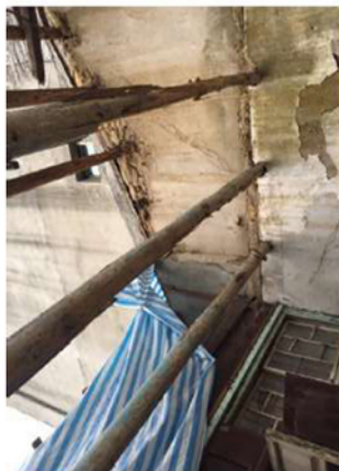
11號前落屋頂及樓拱之原木樑、樑洞
